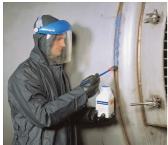
Avesta BlueOne™ Beizpaste 130 – Beizen mit Pinsel, beste anwendbare Technik.
